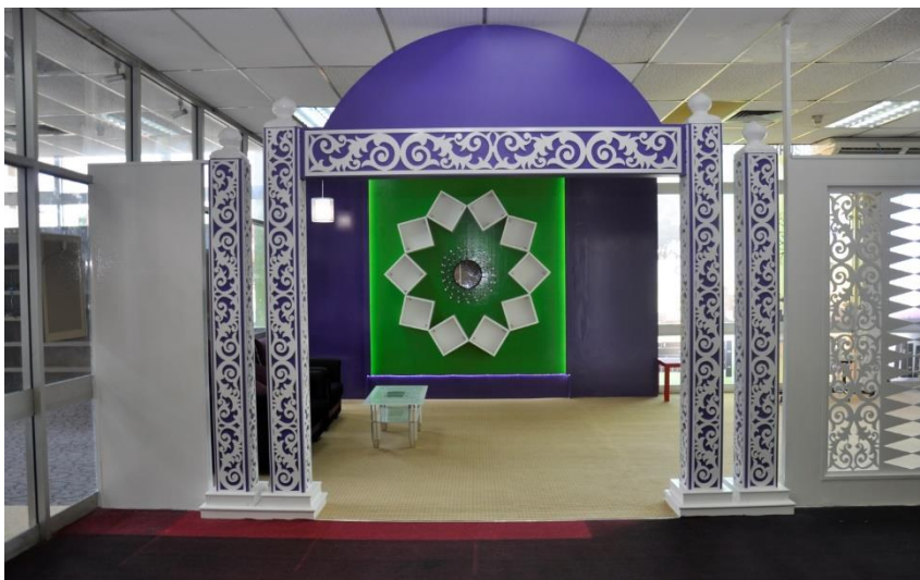
Pusat Sumber Sayyidatina Hafsa yang sedang dalam proses renovasi, berlokasi di Perbadanan Perpustakaan Awam Kelantan
